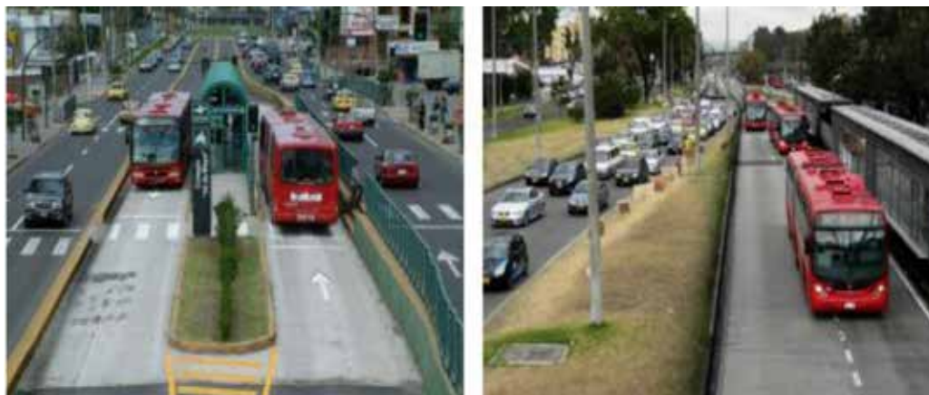
Figura 3.2. Derecho de vía tipo B
